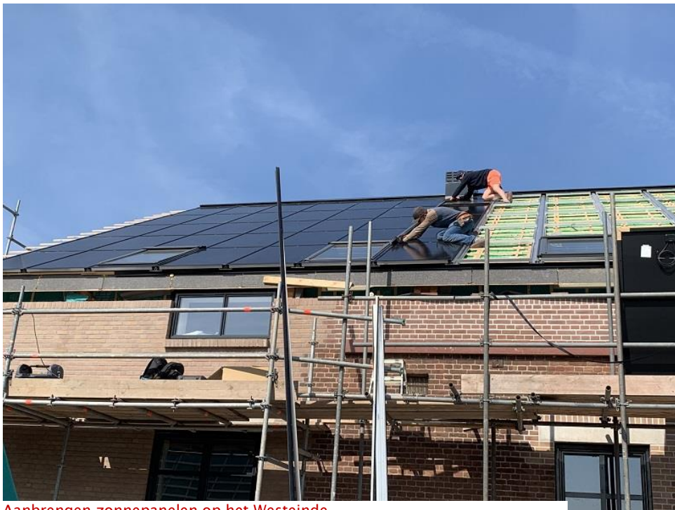
Aanbrengen zonnepanelen op het Westeinde
