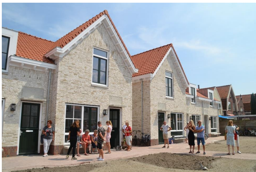
De nieuwe Romeinhof verwarmd met Hr-ketel en Luchtwarmtepomp
